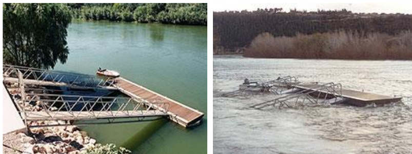
Sl. 2.1-7 Primjer pontona s pristupnim mostom
