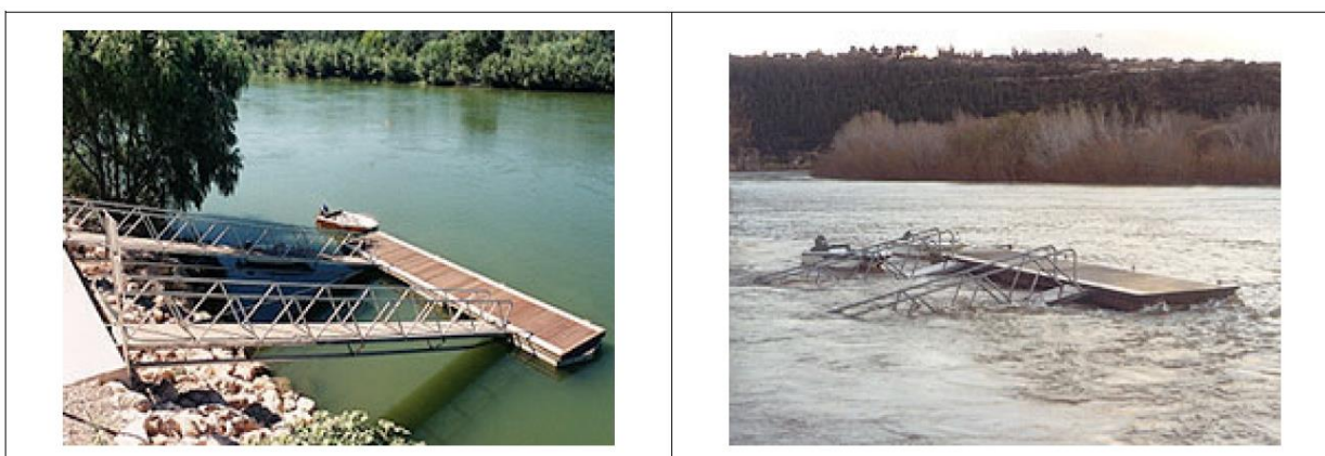
Sl. 2.1-6 Primjer pontona s pristupnim mostićem
